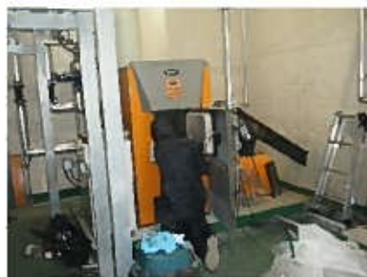
バイオマスボイラーの点検
